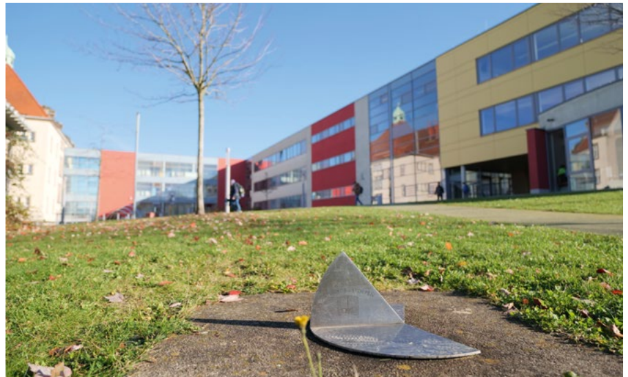
Beim Ferdinand-Sauerbruch-Gymnasium und der Oberschule Rödertal heißt Nachbarschaft nicht nur nebeneinander, sondern vor allem miteinander.
