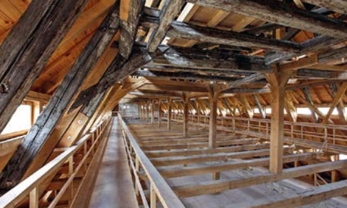
Zwickau, Niederes Kornhaus, Dachstuhl
